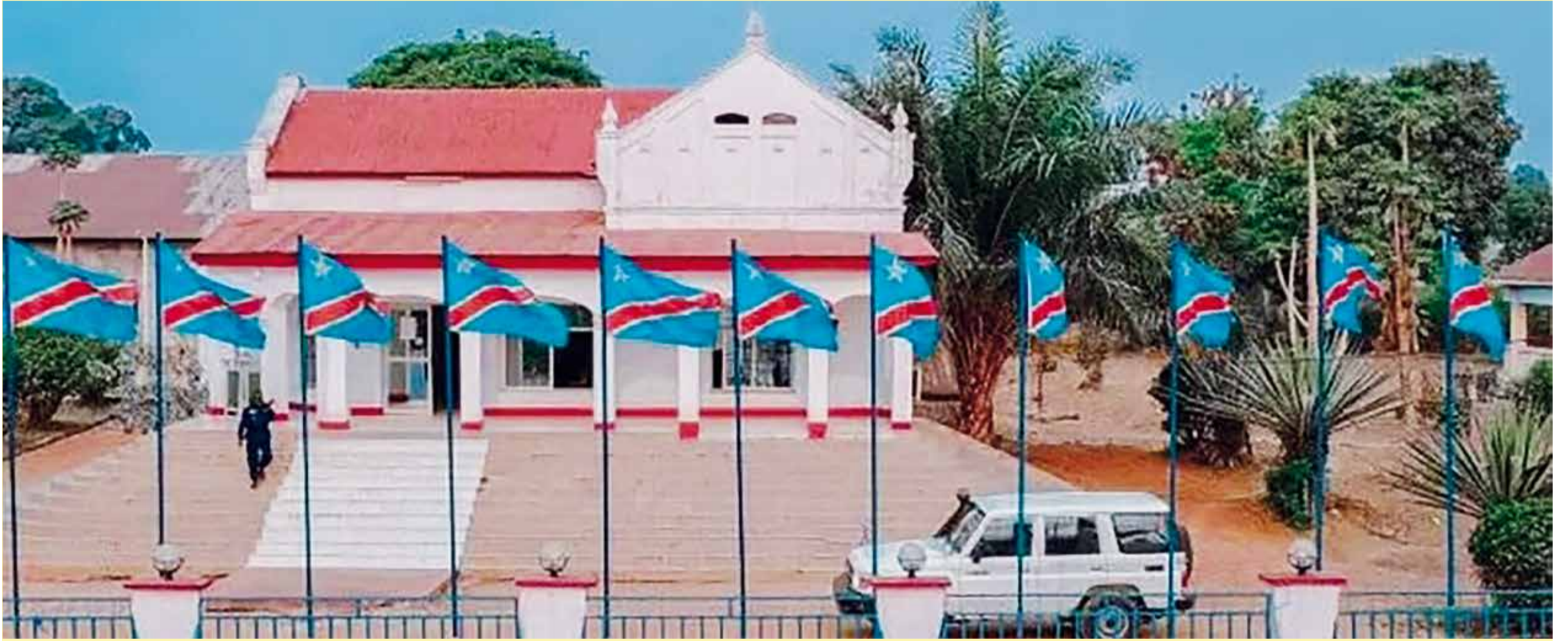
Le siège de l'Exécutif du Kwilu à Bandundu Ville, qui loge les bureaux du Gouverneur, en plein cœur de la ville, symbole de l'État. DR.
